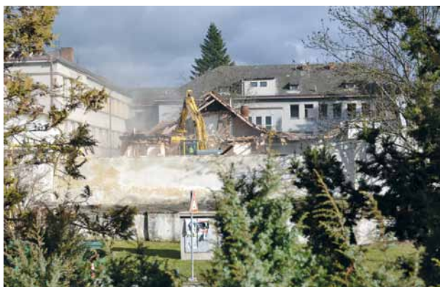
Obr. 7. Domažlice, areál bývalé nemocnice na začátku bouracích prací. Pohled od západu. (Fotoarchiv Národního památkového ústavu, ú. o. p. v Plzni, foto S. Plešmíd, 6. 2. 2013)
