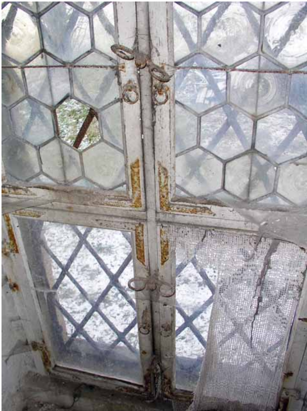
Obr. 14. Žebnice, fara. Okno na sever v prostoru schodiště v patře – detail. Okno je původní barokní, ale jeho kování bylo jednodušší než v obytných místnostech. Zachoval se původní barokní kříž. Horní křídla mají zachované skleněné výplně z terčů fasetovaných do olova. Zavětrování kovovými tyčkami (u dolních křídel chybí). U obou křídel zůstaly zachovány drobné přítuhy v podobě zavěšených kroužků a oboustranné motýlky. (Foto P. Vlček, 2008)
