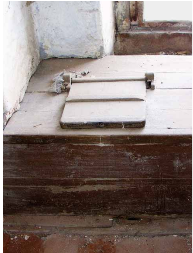
Obr. 15. Žebnice, fara. Záchodový sedák v mezipatře se zachovaným otočným závěrem. Pokud není barokního původu, pak nepochybně vznikl nejpozději v 1. polovině 19. století. (Foto P. Vlček, 2008)
