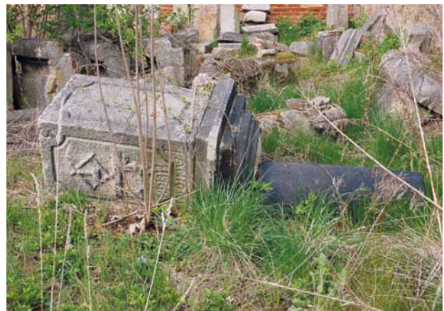
Obr. 16. Plzeň-Křimice, areál zámku, torzo sloupu s Pannou Marií Svatohorskou. 1737. Podstavec s římsou, plintem, patkou a oddělenou spodní částí dřívku, ležící na zemi. (Foto V. Kovařík, 2006)
