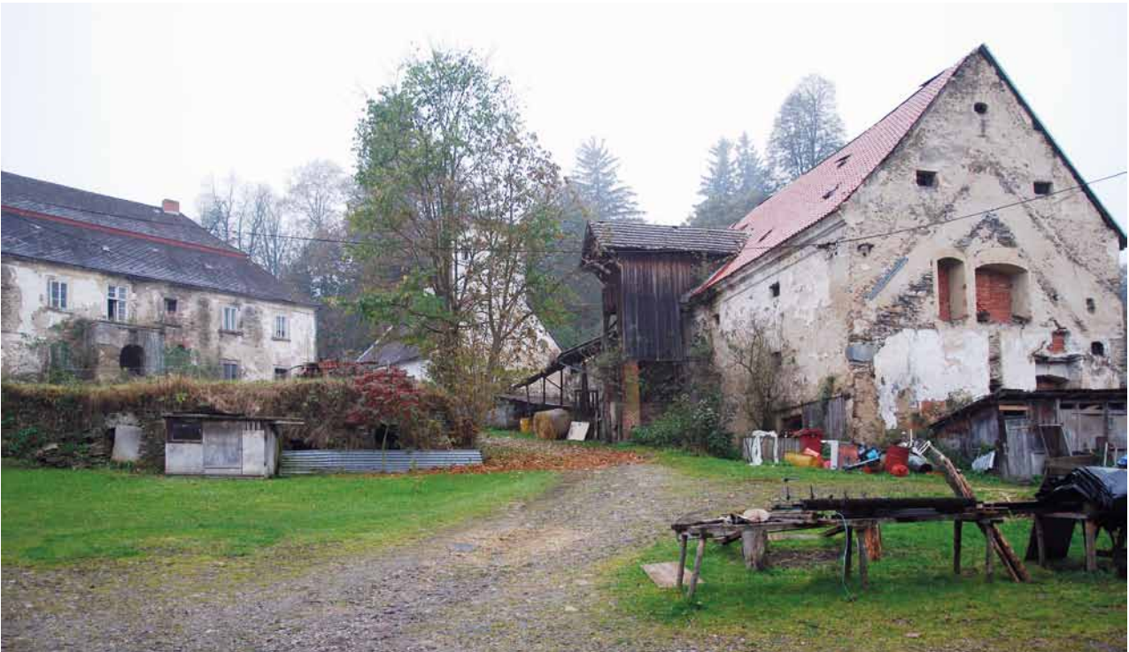
Obr. 7. Hlavňovice (okr. Klatovy), areál zámku a poplužního dvora. Zcela vpravo budova sladovny s otisky konstrukcí zbořeného pivovaru na fasádě. Terasa před zámkem (vlevo) obsahuje pivovarské sklepy. (Foto J. Anderle, 2008)
