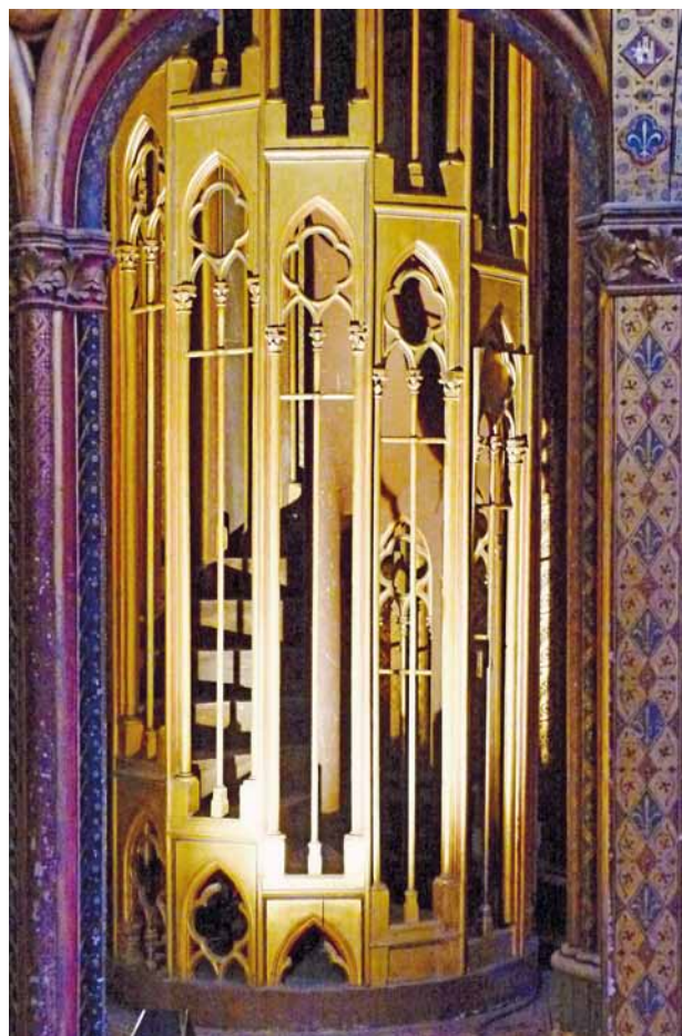
Obr. 6. Paříž, Sainte-Chapelle, horní kaple. Pohled na jedno ze dvou točitých vřetenových schodišť umístěných po stranách novogotického hlavního oltáře jako jeho součást. (Foto P. Kováč, 2002)
