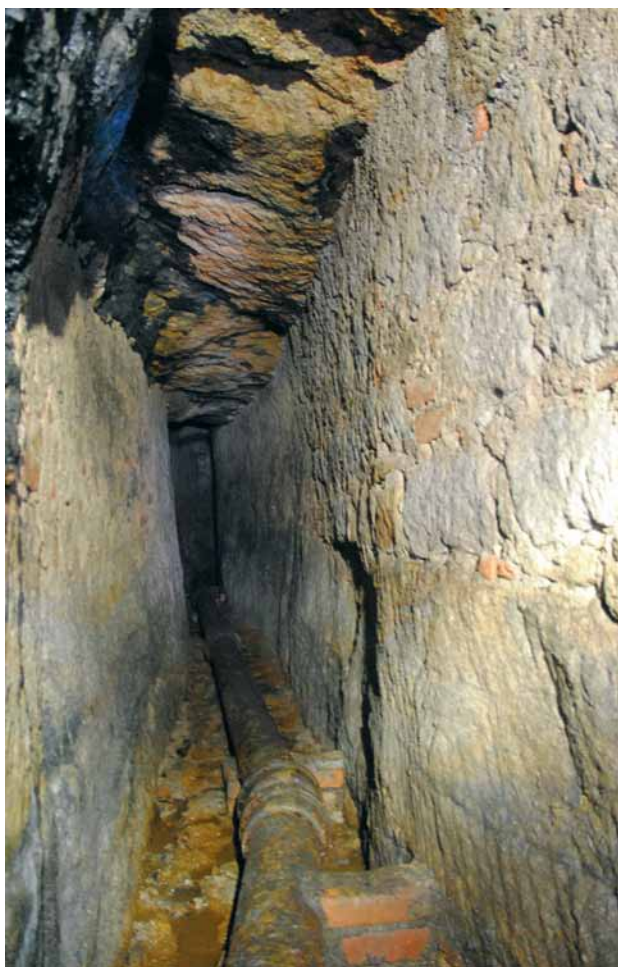
Obr. 9. Plzeň, štola U Všech svatých, jižní úsek. Lokální úpravy ze smíšeného zdiva, žíla černého uhlí je vidět nahoře u stropu. (Foto M. Strejc, 2012)
