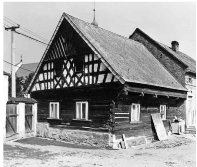
Obr. 8. Úněšov (okr. Plzeň-sever), budova čp. 1, obytné stavení. Roubený objekt s hrázděným štítem z 19. století byl v době někdy kolem roku 1981 převezen do Klenovic (okr. Plzeň-sever) a tam při použití původních hodnotných konstrukcí nově postaven a upraven k rekreačním účelům (objekt č. E 16). (Foto J. Gryc, 1979)
