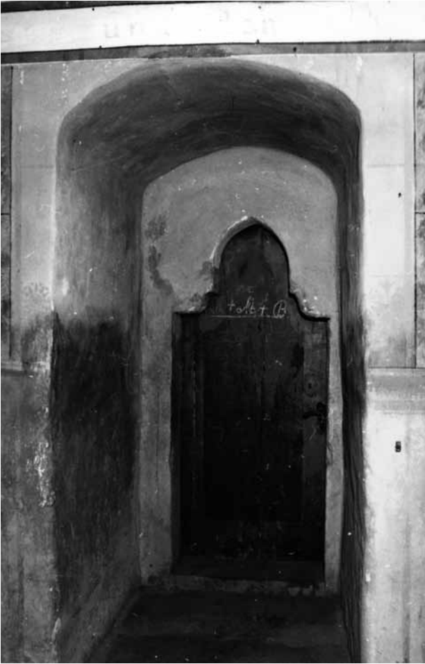
Obr. 4. Mělnice, kostel sv. Jiljí. Západní portálek do lodi z přízemí věže – pohled v lodi na portálovou niku a rub portálku. (Fotoarchiv Národního památkového ústavu, ú. o. p. v Plzni, foto R. Koderá, 1997)
