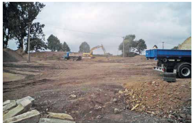
Obr. 4. Tisová, prostor uvolněný demolicemi budov v jihozápadní části hospodářského dvora. Pohled od kostela po dokončení bouracích prací a během terénních úprav těžkou stavební technikou. (Foto N. Rayman, 1. 9. 2012)
