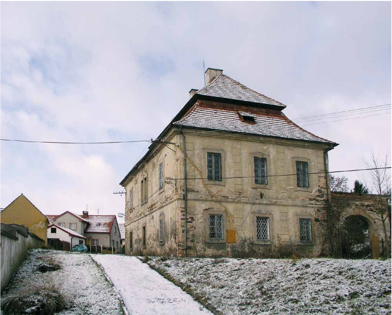
Obr. 7. Žebnice, fara. Pohled od východu. (Foto P. Vlček, 2008)
