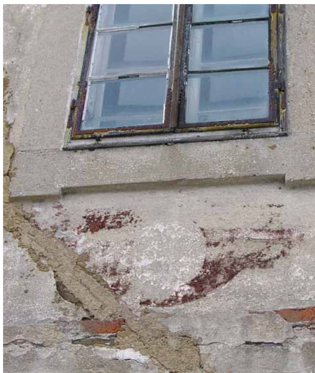
Obr. 6. Žebnice, fara. Východní fasáda. Zbytek malované čabranky na parapetu pod oknem v patře (původní barevnost byla cihlově červená). Asi součást úpravy z konce 18. století. (Foto P. Vlček, 2008)
