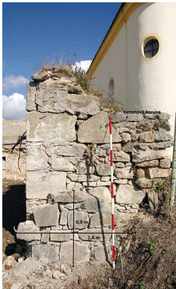
Obr. 8. Tisová, konstrukce B. Armované nároží a krátký úsek jižní ohradní zdi areálu kostela s recentními úpravami. Pohled z jihu. (Foto L. Foster, 2012. Grafické úpravy M. Waldmannová, 2013)
