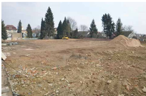
Obr. 8. Domažlice, prostor uvolněný demolicemi budov bývalé nemocnice. Pohled od severozápadu. (Foto J. Kaigl, 29. 3. 2013)
