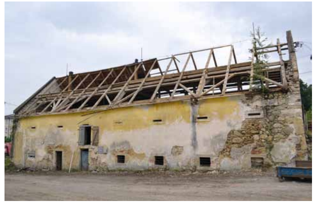
Obr. 2. Tisová, špýchar v areálu hospodářského dvora. Pohled od severu po zahájení bouracích prací. (Fotoarchiv Národního památkového ústavu, ú. o. p. v Plzni, foto S. Plešmíd, 25. 7. 2012)
