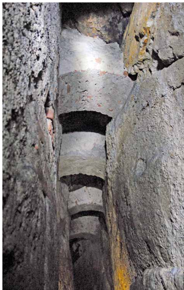
Obr. 10. Plzeň, štola U Všech svatých, střední úsek. Segmentové klenební pasy z cihel vznikly při rekonstrukci štoly v polovině 19. století. (Foto M. Strejc, 2012)
