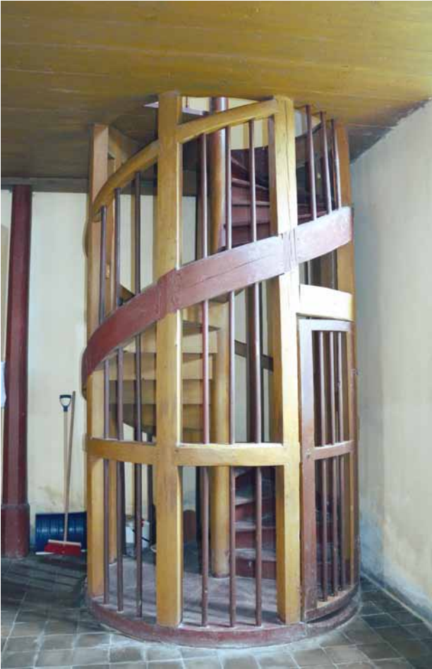
Obr. 12. Vrčeň (okr. Plzeň-jih), kostel sv. Vavřince. Točité vřetenové schodiště na hudební kruchtu. (Foto P. Kroupa, 2013)
