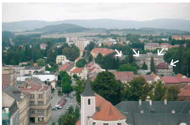
Obr. 6. Domažlice, výhled z městské věže-hlásky na historickém hlavním náměstí směrem na západ a severozápad. Šipkami jsou vyznačeny pouze některé, nejlépe viditelné budovy bývalé nemocnice. (Fotoarchiv Národního památkového ústavu, ú. o. p. v Plzni, foto M. Bašta, 2011)
