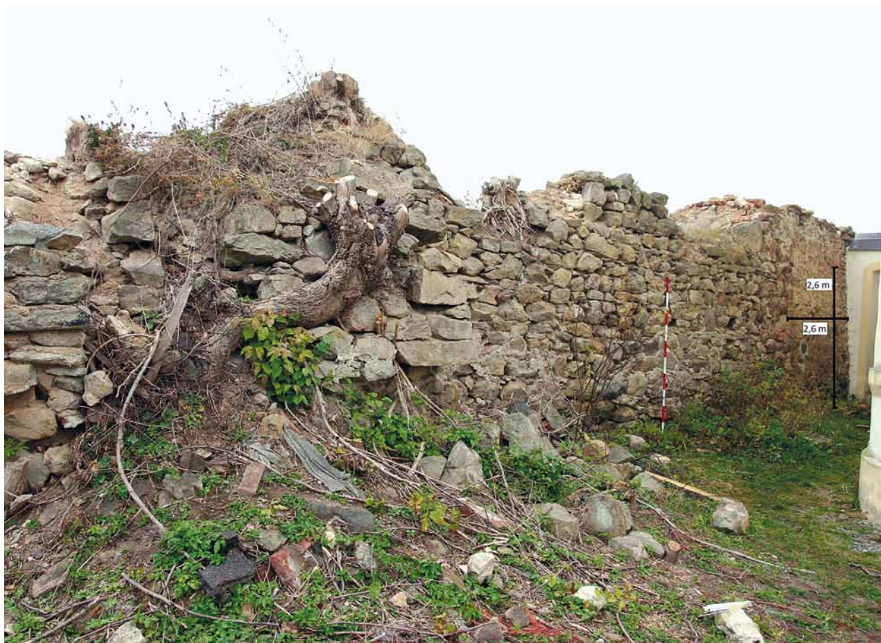
Obr. 11. Tisová, ohradní zeď areálu kostela sv. Mikuláše. Východní líc konstrukce B. Vyznačen upravený severní úsek (u zděné branky) včetně náznaku výšky zazděného okénka se segmentovým záklenkem. Pohled od jihovýchodu. (Foto L. Foster, 2012. Grafické úpravy M. Waldmannová, 2013)
