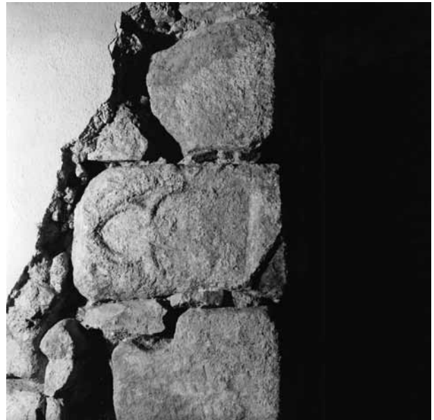
Obr. 17. Loučim, kostel Narození Panny Marie. Špaleta průchodu v přízemí z lodi do věže s nálezem druhotně použitého kamenného kusu se slepou kružbou, původem nejspíš z gotického západního vstupního portálu. (Fotoarchiv Národního památkového ústavu, ú. o. p. v Plzni, foto R. Kodera, 1997)
