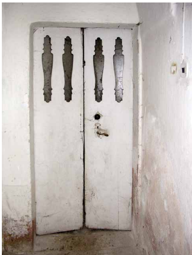
Obr. 12. Žebnice, fara. Původní barokní dvoukřídle dveře, které uzavírají vchod v přízemí na schodiště do patra. Zachovalo se kompletní kování, včetně závěsů, zámku, klikového štítku kliky a také průtuhy. (Foto P. Vlček, 2008)
