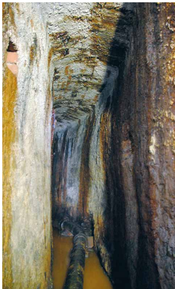
Obr. 12. Plzeň, štola U Věch svatých, střední úsek. Hrubě omítnuté cihlové přízdívky stěn, segmentová klenba. Vlevo nahoře na snímku je vidět malá osvětlovací nika. (Foto M. Strejc, 2012)
