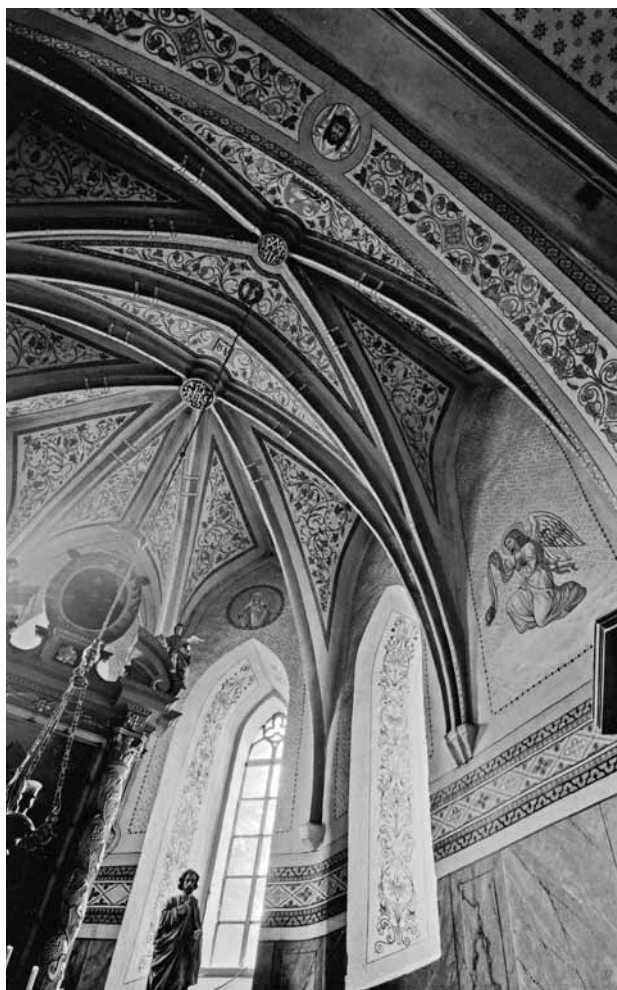
Obr. 2. Mělnice, kostel sv. Jiljí. Pohled do jižní části žebrových kleneb v presbyteriu. (Fotoarchiv Národního památkového ústavu, generální ředitelství, foto V. Uher, 1981)
