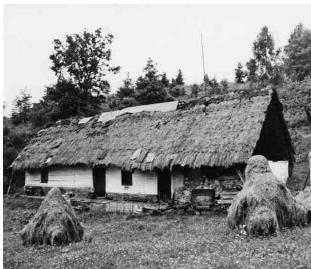
Obr. 9. Všehrady (okr. Plzeň-sever), chalupa čp. 8. Roubená stavba s doškovou střechou, pocházející z 19. století, byla po předchozím zrušení památkové ochrany v roce 1981 odstraněna. (Foto J. Gryc, 1975)
