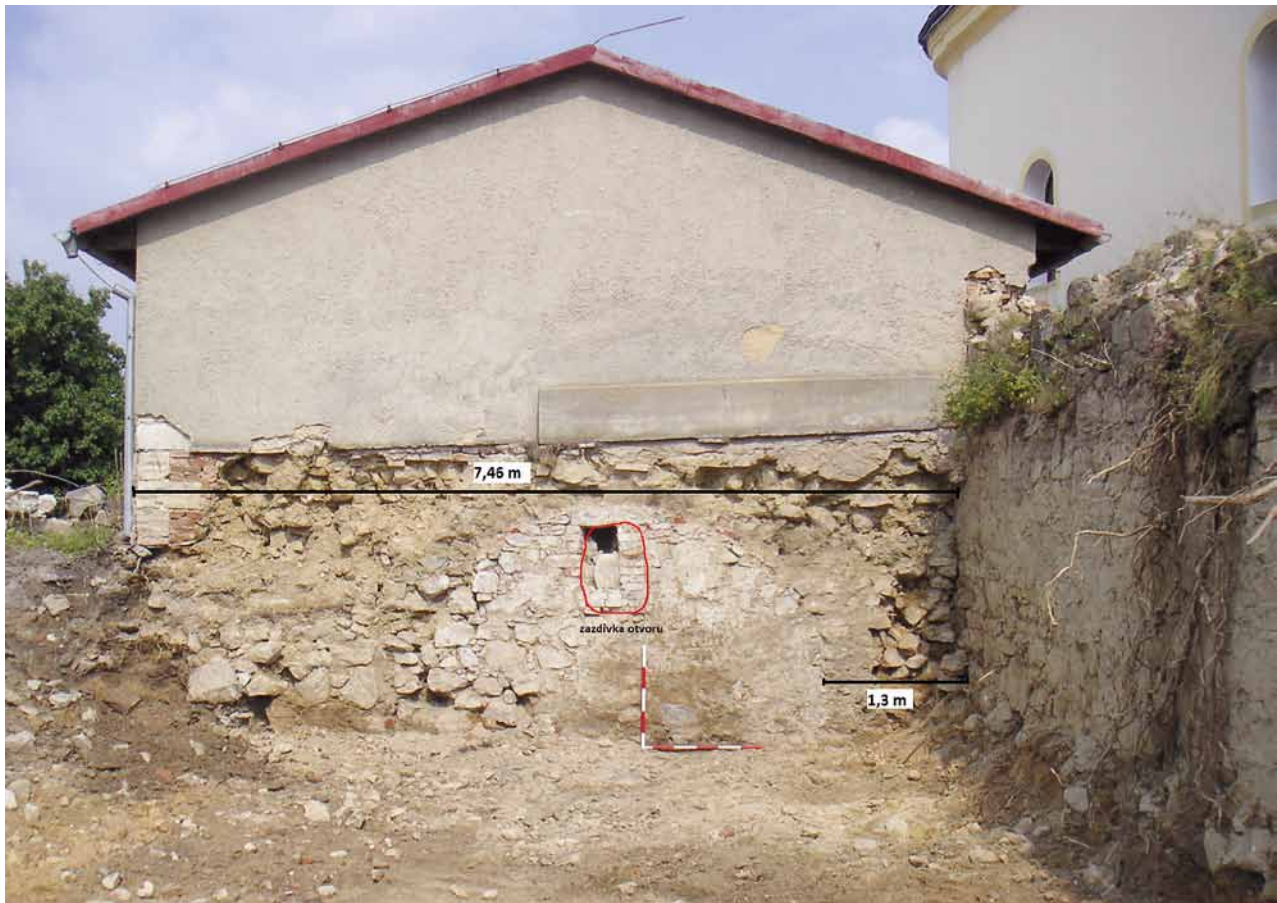
Obr. 5. Tisová, jižní štítové průčelí budovy na stpč. 41/12. V popředí demolice polozapuštěného objektu s valenou klenbou. Konstrukce A s patrným otiskem valené klenby a zčásti zazděným okenním (větracím) otvorem s kamenným překladem. (Foto s grafickými úpravami M. Waldmannová, 2012)
