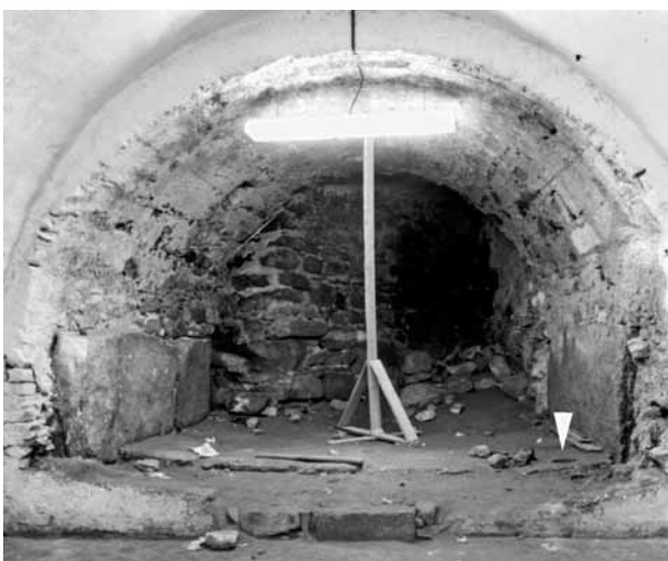
Obr. 12. Chanovice, zámek. Sladovna s pozůstatky náduvníku (přední a zadní bok odstraněn). Vlevo v klenbě šikmý otvor pro přítvod vody. Ve vrcholu klenby je sypací otvor. Šipka označuje výpustný otvor. (Foto J. Anderle, 1994)
