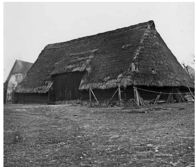
Obr. 6. Dolany (okr. Plzeň-sever), stodola při objektu čp. 1. Vznik polygonální roubené stavby s doškovou střechou byl datován hluboko do 18. století. V 80. letech 20. století byla stodola vytipována jako nejhodnotnější dochovaná stavba svého druhu na severním Plzeňsku a byl zvažován její transfer. Demolována krátce po zrušení památkové ochrany. (Foto K. Tůma, 1962)
