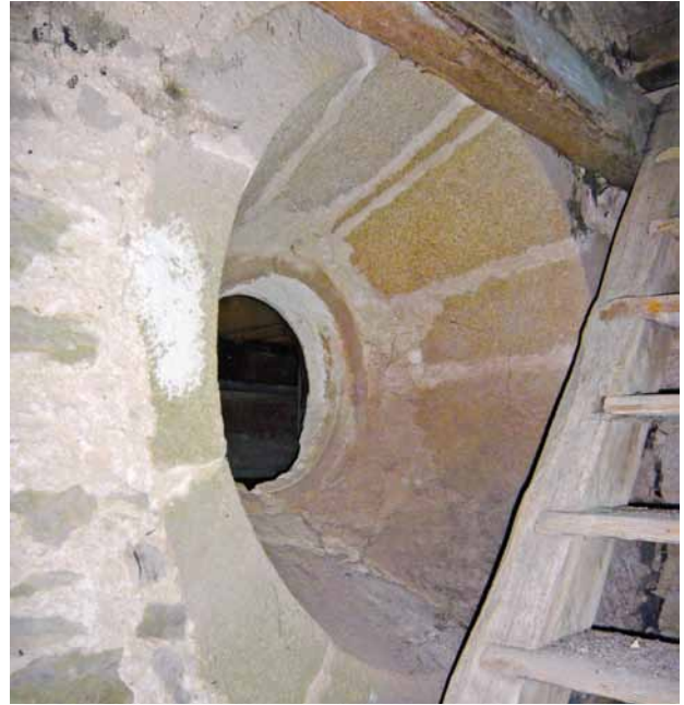
Obr. 5. Mělnice, kostel sv. Jiljí. Rozeta někdejšího gotického západního průčelí. Pohled v 1. patře věže. (Foto J. Kaigl, 2008)
