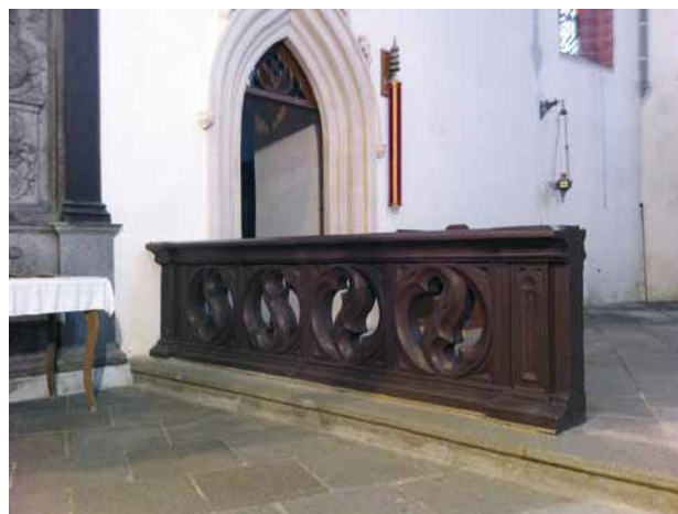
Obr. 10. Nepomuk, kostel sv. Jakuba. Pohled na severní úsek kružbového zábradlí v presbyteriu. (Foto P. Kroupa, 2013)
