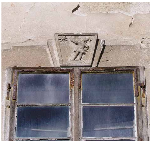
Obr. 8. Žebnice, fara. Východní fasáda. Detail horní části středního okna v patře s kamenným ostěním a klenákem, jež je opatřen reliéfem rytíře. Vnější lícované okno má zvenčí pozdně barokní kování, zevnitř je kování vrcholně barokní, použité druhotně. (Foto P. Vlček, 2008)
